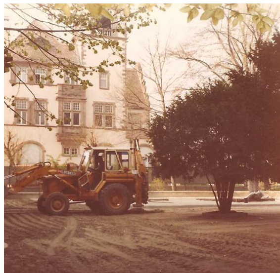
Pose du « macadam » dans la cour
